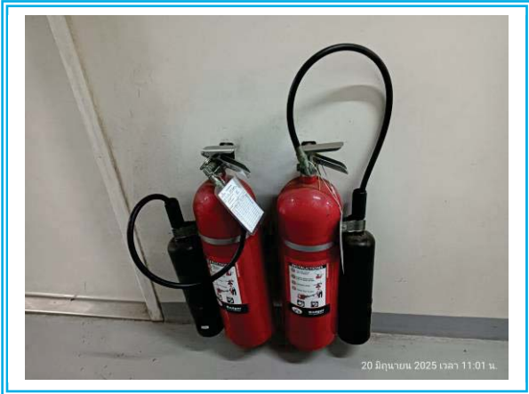
รูปที่ 3-45 การติดตั้งถังดับเพลิงแบบมือถือ บริเวณจุดต่างๆ ภายในอาคาร
