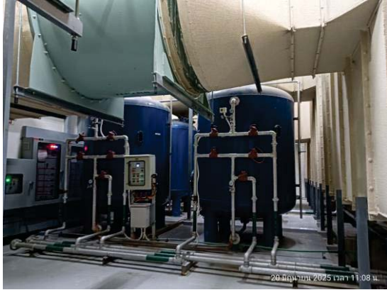
รูปที่ 3-29 ระบบถังกรองน้ำเสียจากระบบบำบัด
