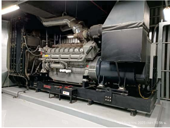
รูปที่ 3-10 ห้อง generator มีการนิวส์ดักกันเสียงไม่ให้มีเสียงดังรบกวนออกไปภายนอก
