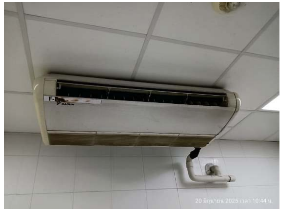
รูปที่ 3-42 ติดตั้งเครื่องปรับอากาศที่มีขนาดเหมาะสมกับ ขนาดพื้นที่ห้อง
