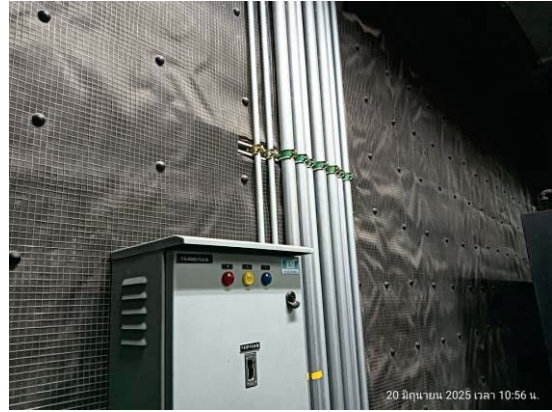
รูปที่ 3-10 ห้อง generator มีการนิวส์ดักกันเสียงไม่ให้มีเสียงดังรบกวนออกไปภายนอก
